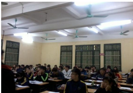
(c) Hệ thống đèn giảng đường C106
