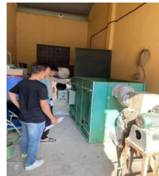
Hình 19. Lắp đặt và khảo nghiệm tổng thể máy sấy
